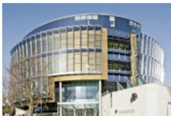
Oltre alle serie base e design, Schüco offre anche soluzioni speciali per facciate a finestre termicamente isolate. Con i sistemi di finestre Schüco è possibile realizzare facciate a finestre omogenee con vetraggi di altezza pari a quelle del piano con l'eleganza della trama a montanti e traversi.
